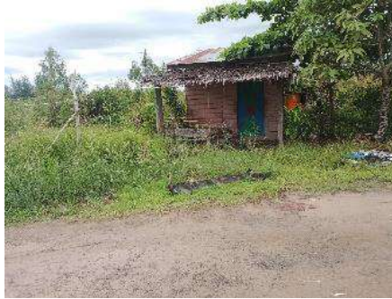
Gambar 13. Kondisi fisik bangunan keluarga di Desa Sungai Perlu
